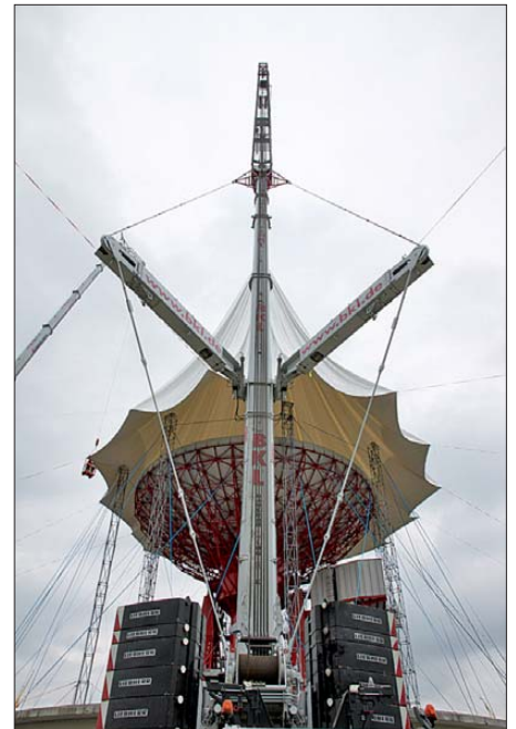
Abnahme der alten Hülle vom Radom am 29.9.10
