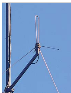
Bild 5: 4-m-Groundplane-Antenne K 5126411 von Kathrein, hier an einem Ausleger montiert
